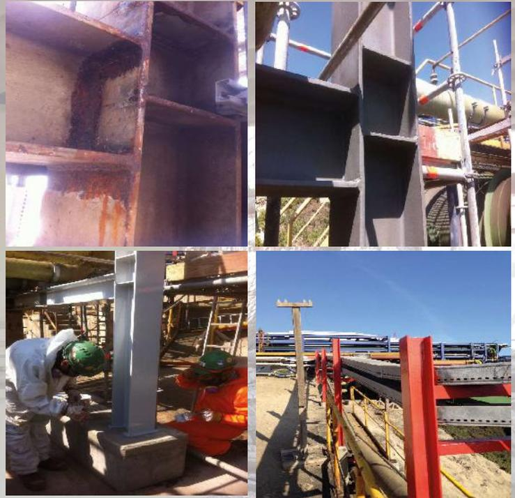
Termoeléctrica Guacolda, Proyecto Retrofit para empresa Andritz Chile, granallado y aplicación de pintura a soportes de ducto.
